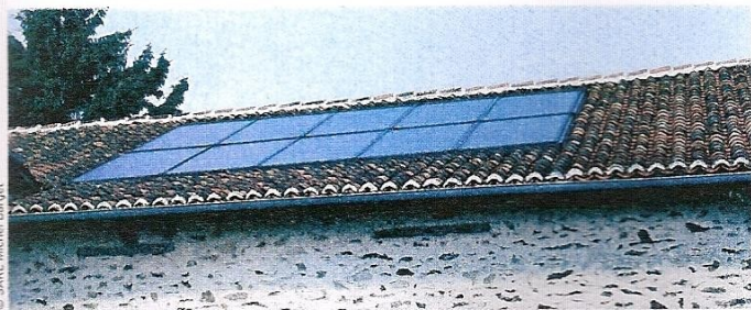
Exemple de réalisation de panneaux solaires par la SARL Michel Barget.
